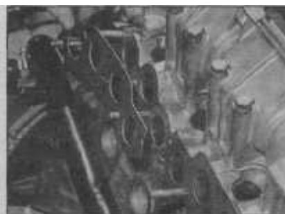
28.20C Удаление коллекторов
